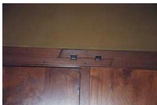
グリーン兄弟は木の部材は力尽くで結合させるのではなく、複雑にかみ合うパズルのように合せなければならないと考えました。つまり、部材達が接合金物を通して一体化し、全体として働くことを重視し、その接合部を芸術作品のように美化していったのです。
